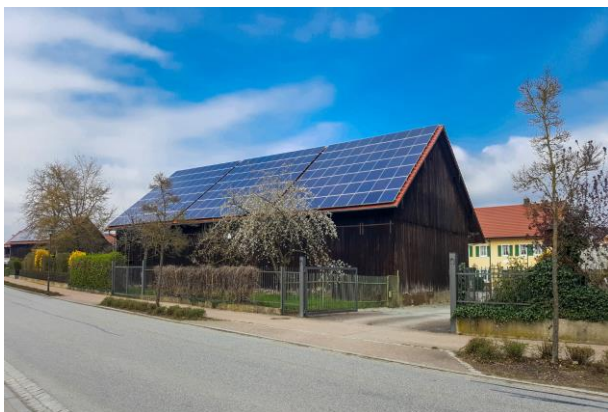
impianto su capannone
