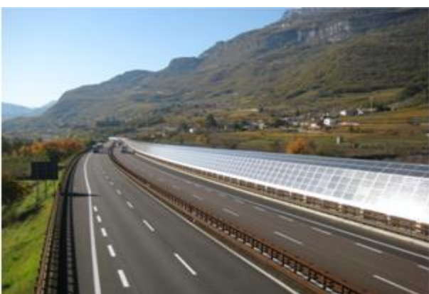
impianto su autostrada (barriera acustica)
